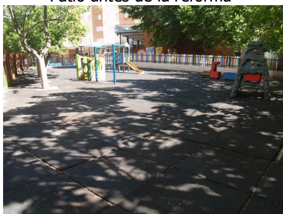
Patio antes de la reforma
